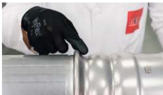
Рис. 36. Визуальный осмотр места прессования Oversize.
